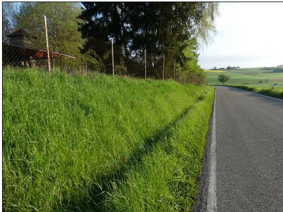
Abb. 12: Böschung zur K 2881 (03.05.2023)
