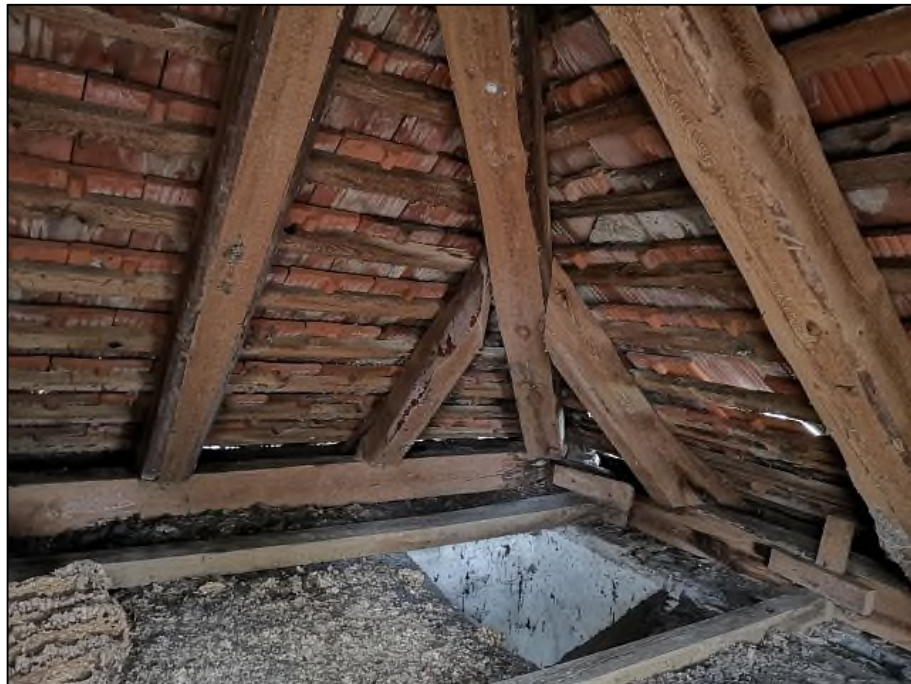
Abb. 6: Dachstuhl des Umspannturms (13.11.2023)
