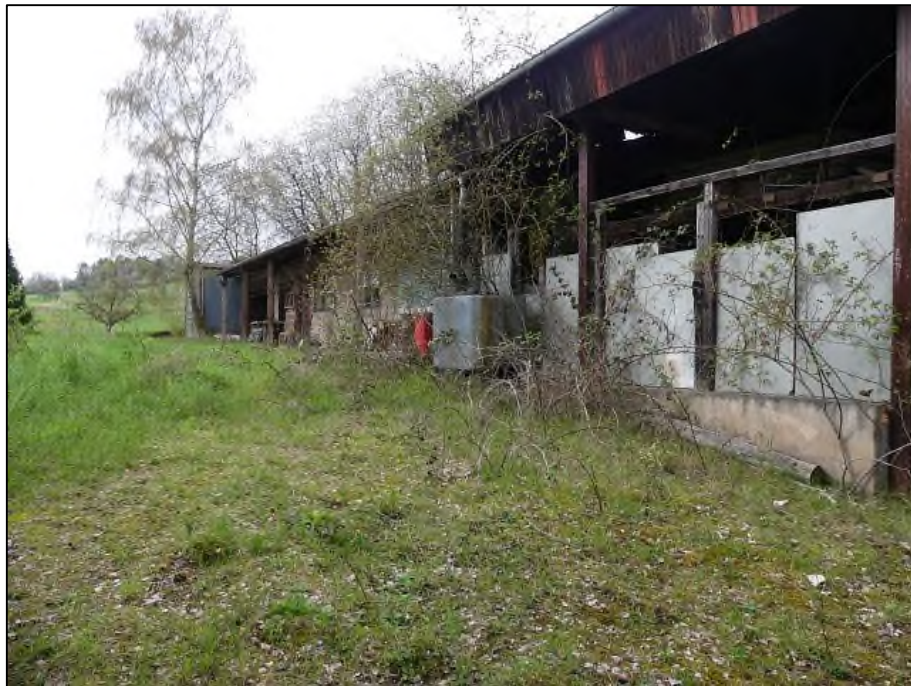
Abb. 9: Betriebsgebäude im Süden des Geltungsbereiches (25.04. 2023)
