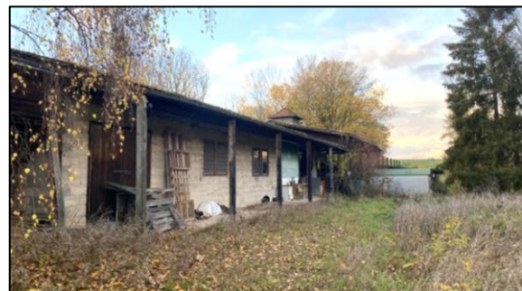
Bild 6: Bestehende Bebauung (Ostseite) auf dem Grundstücks Nr. 5888, Blick in Richtung Norden
