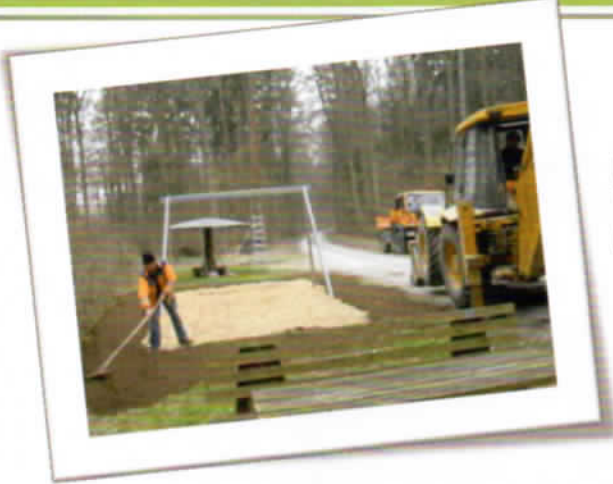
Mitarbeiter des Bauhofs stellen im Waldgebiet „Schönert“ eine neue Kinderschaukel auf.
