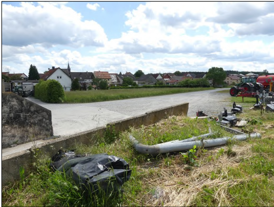
Abb. 5: Versiegelte und geschotterte Flächen im Westen des Geltungsbereiches (25.5.2022)
